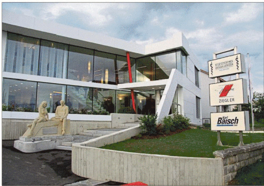
Das neu entstandene moderne Bauwerk in Neuhausen. Zur Einweihung gab es einen „großen Bahnhof“.
